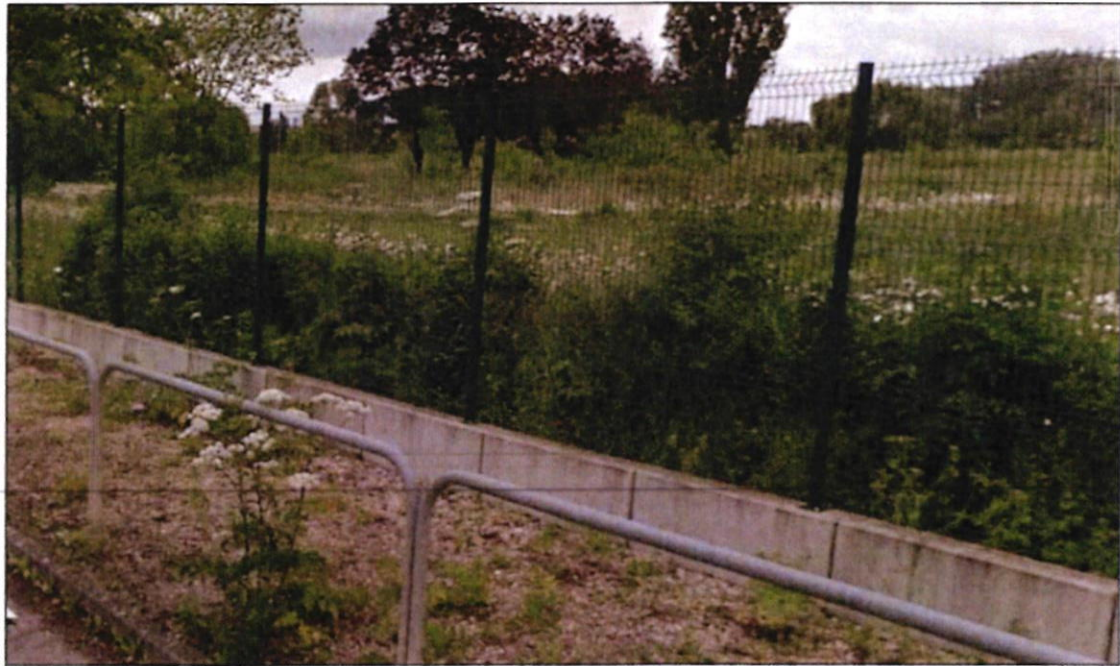
Clôture existante conservée et complétée (soubassement en béton; poteaux en acier galvanisé plastifiés de couleur vert mousse (RAL 6005); un grillage maillé 200/55mm en acier galvanisé de couleur vert mousse (RAL 6005) hauteur 2m.
